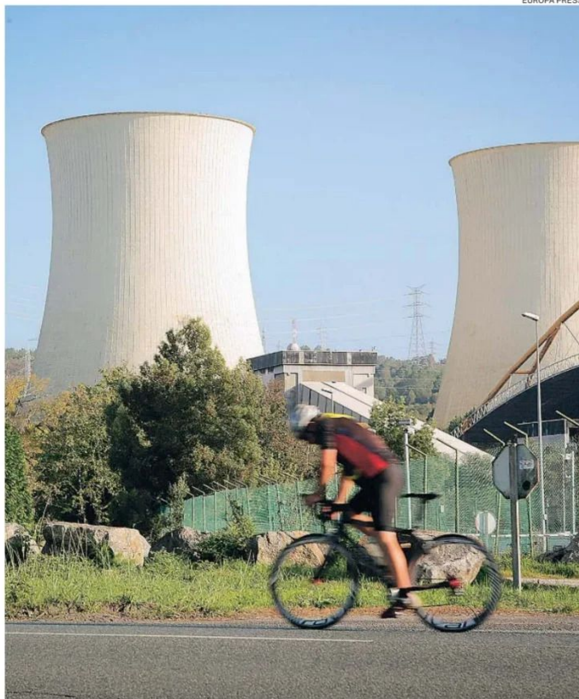
Vista de la central térmica de As Pontes, en La Coruña
